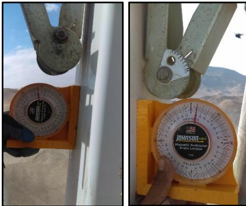
Figura N° 16: Configuración del Tilt mecánico – Sector 1 y Sector 2 – BTS Locumba. Fuente: Obtención Propia
