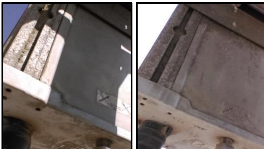
Figura N° 16: Configuración del Tilt mecánico – Sector 1 y Sector 2 – BTS Locumba. Fuente: Obtención Propia
