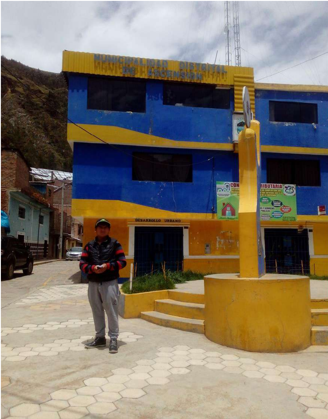
Foto N° 1 - MUNICIPALIDAD DISTRITAL DE ASCENSIÓN
