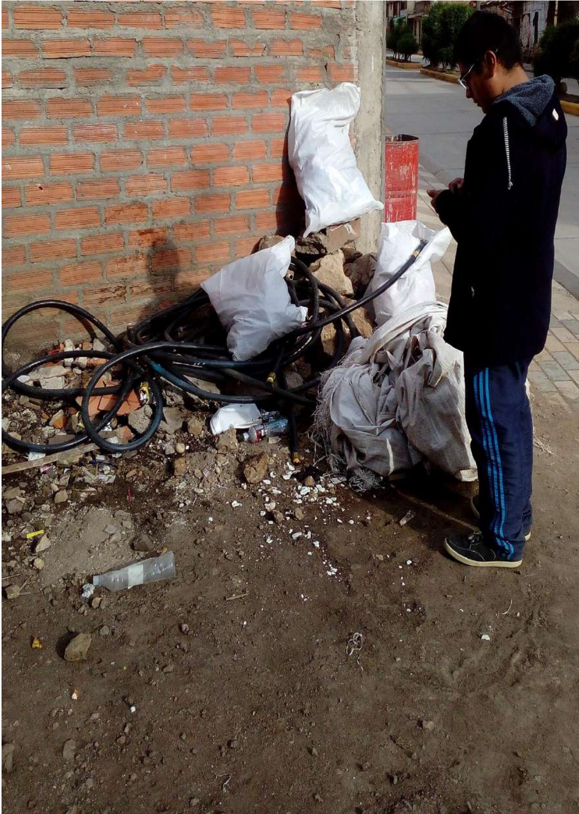
Foto N° 10 - PUNTO CRÍTICO SALIDA DE CARRETERA HV-128
