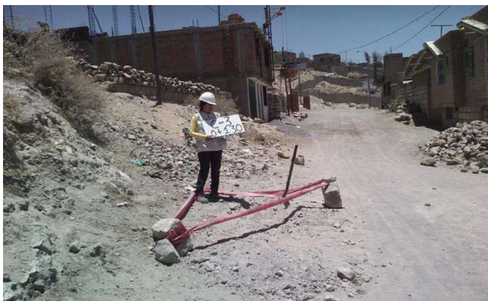
Figura 5.4: Excavación de calicata 03
