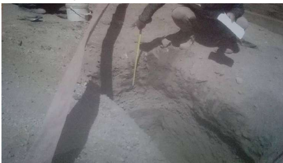
Figura 5.9: Excavación de calicata 08
