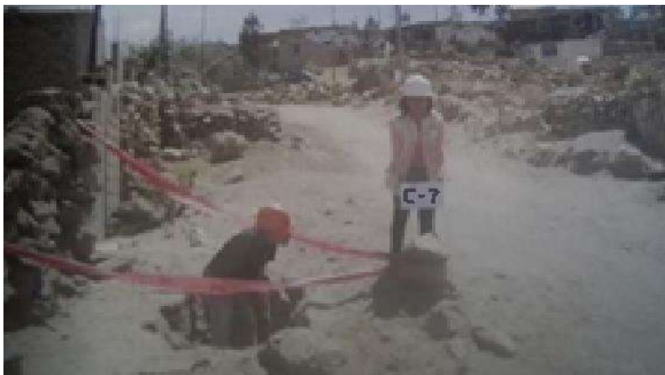
Figura 5.8: Excavación de calicata 07
