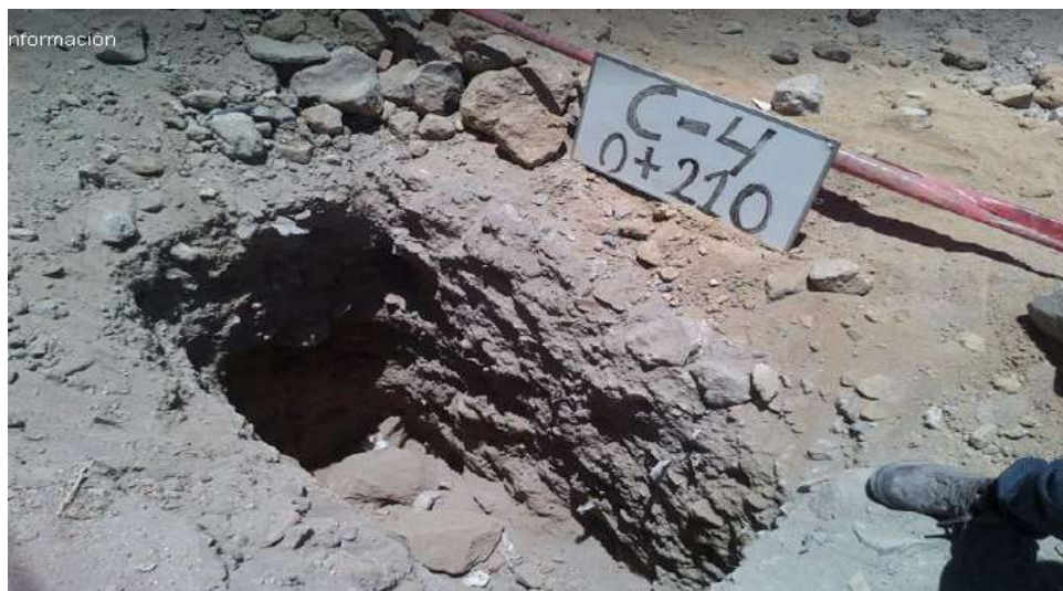
Figura 5.5: Excavación de calicata 04
