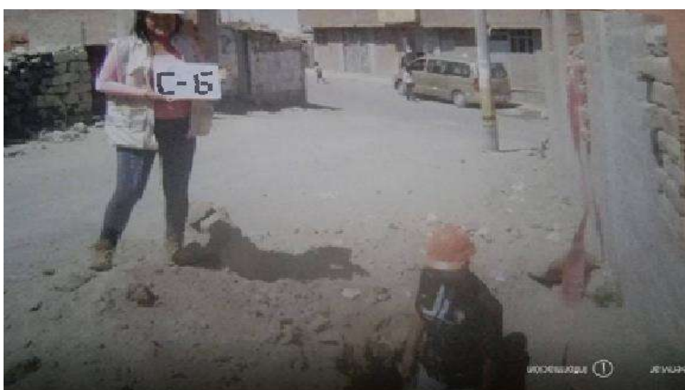
Figura 5.7: Excavación de calicata 06
