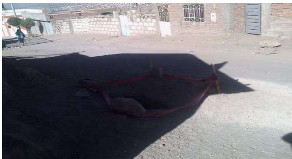
Figura 5.6: Excavación de calicata 05
