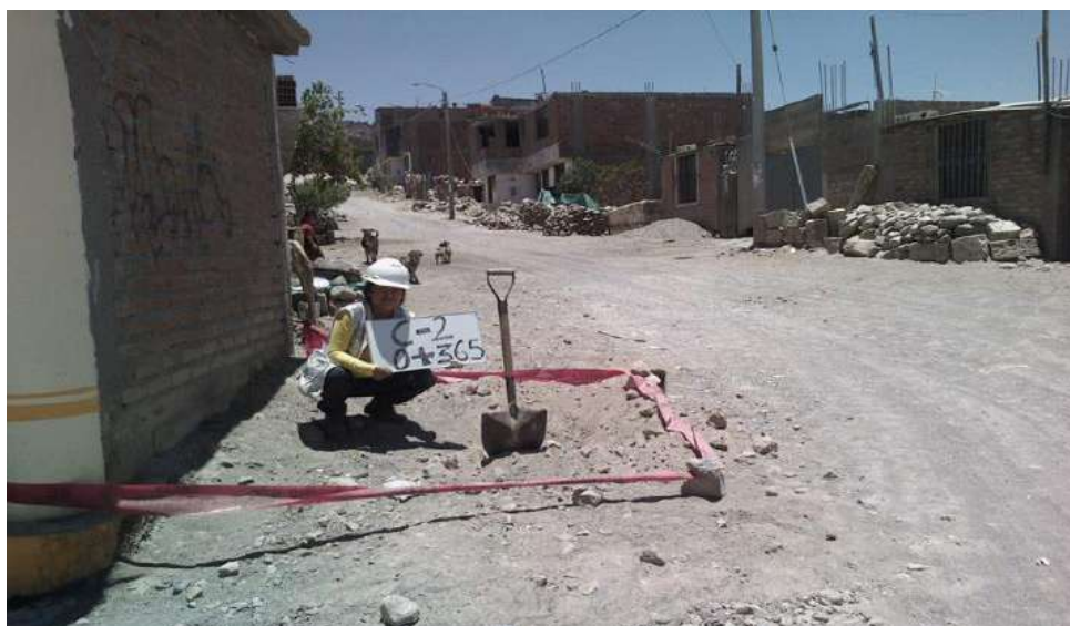
Figura 5.3: Excavación de calicata 02
