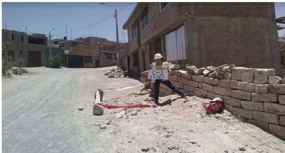
Figura 5.2: Excavación de calicata 01
