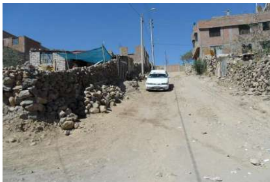
Figura 3.29: Calle 12 de octubre
