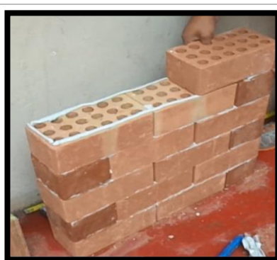
Fig.24.4.-colocación del ladrillo
