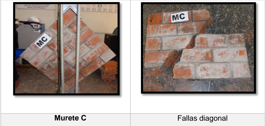
Figura 23.3: Fallas de murete C mortero tradicional.
