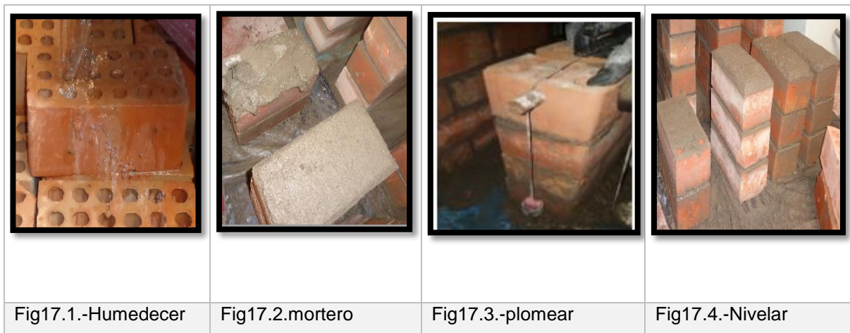
Figura 17: proceso constructivo de pilas con mortero tradicional
