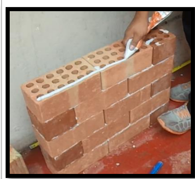
Fig.24.3.-aplicación del massa dun dun
