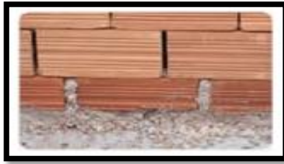
Figura 04: Nivelación con mortero
