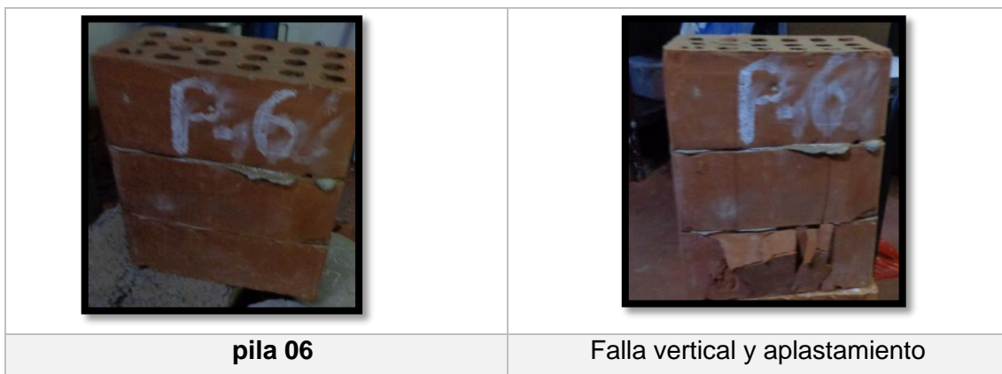
Figura 20.5: falla de las pilas 06
