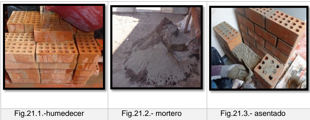
Figura 21: Proceso constructivos de muretes con mortero tradicional
