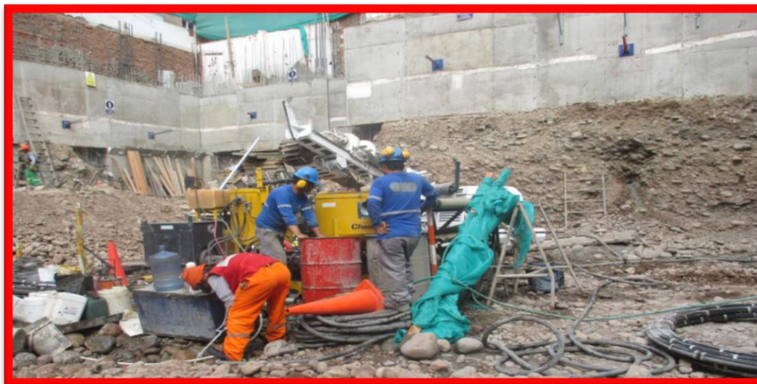
Figura 2. Inyección de concreto.
