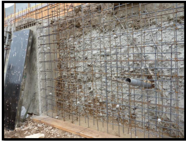
Fig. 2.1.2.3.5 Colocación de tabla de madera de apoyo para el encofrado.
