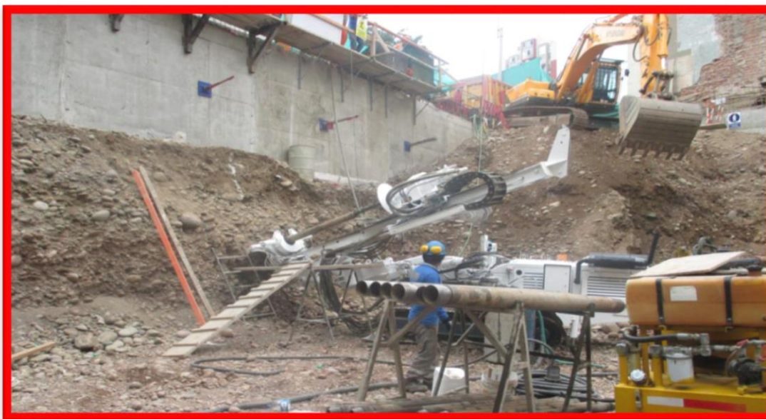
Figura 1. Taladrado de terreno para recibir a los cables de anclaje. 0.1
