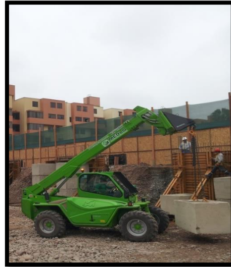
Fig. 2.1.2.3.7. Maquinaria Merlo trasportando bloques de concreto.
