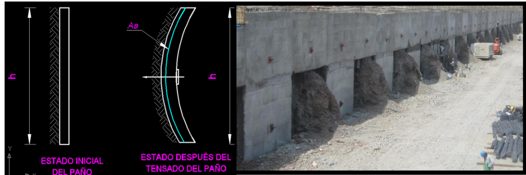
Fig. 2.1.2.2.2 A la izquierda se puede observar el estado inicial de los paños (ABBINGS 2010, Conferencia de muros anclados). A la derecha se puede observar los muros del segundo anillo se encuentran en el estado inicial, mientras los muros del primer anillo se encuentran en el estado intermedio.
