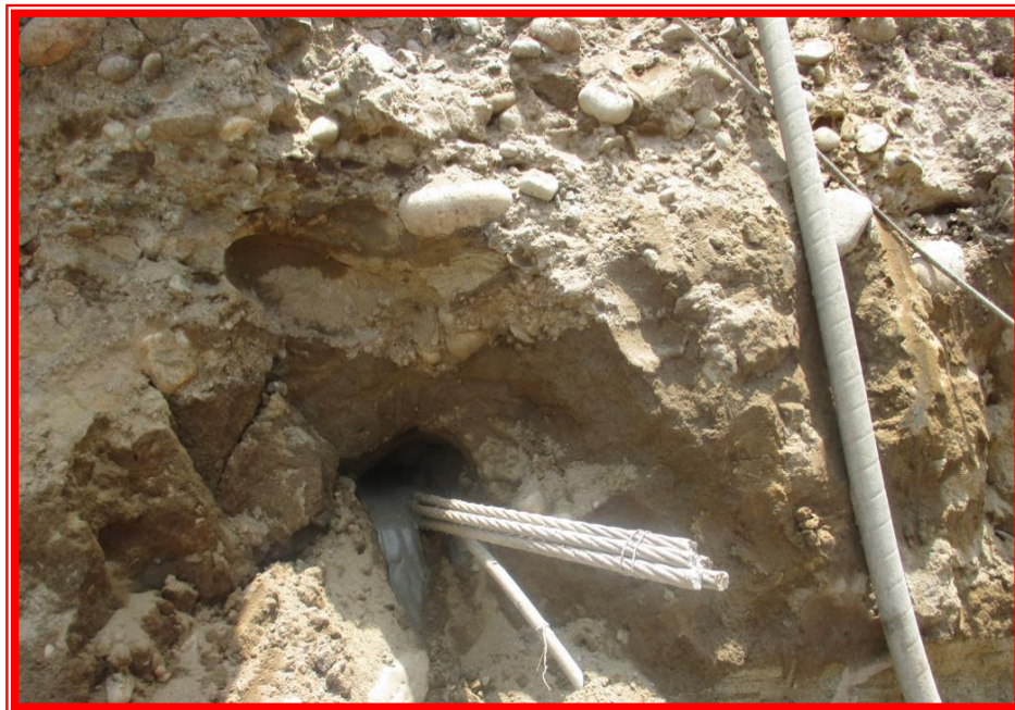
Figura 3. Inyección de concreto en cables de anclaje
