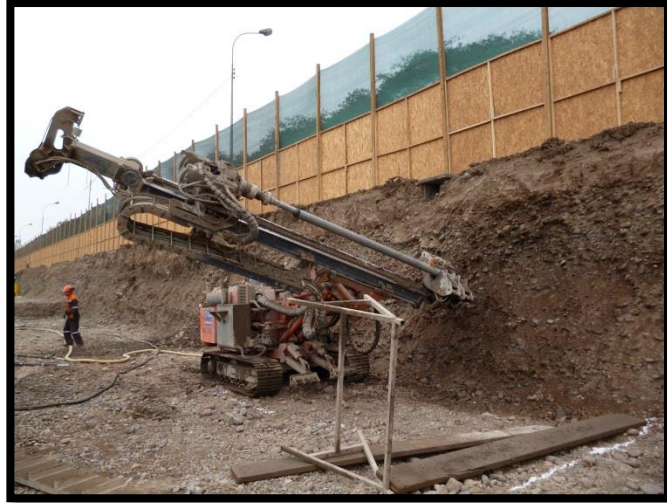
Fig. 2.1.2.3.2 Perforación, colocado de cables metálicos e inyectados de grout.
