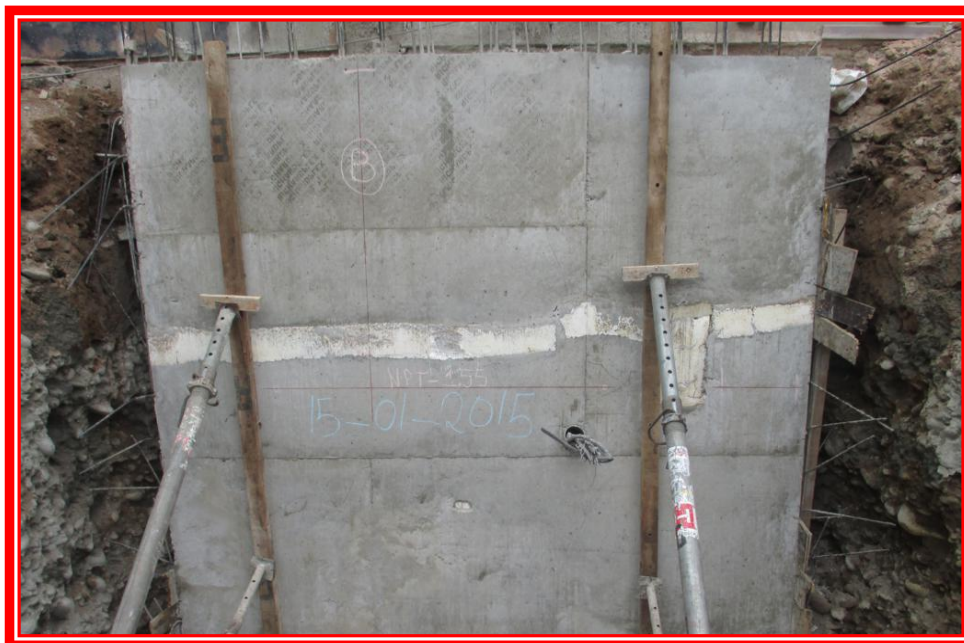
Figura 9. Ejecución de banquetta para encofrado con retroexcavadora
