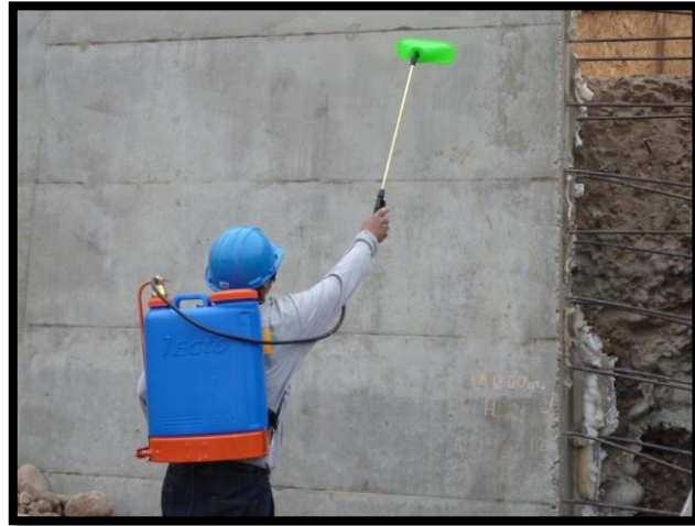
Fig. 2.1.2.3.11 Curado del concreto de los muros.
