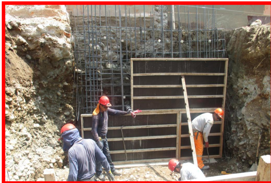
Figura 6. Encofrado de Muros anclados
