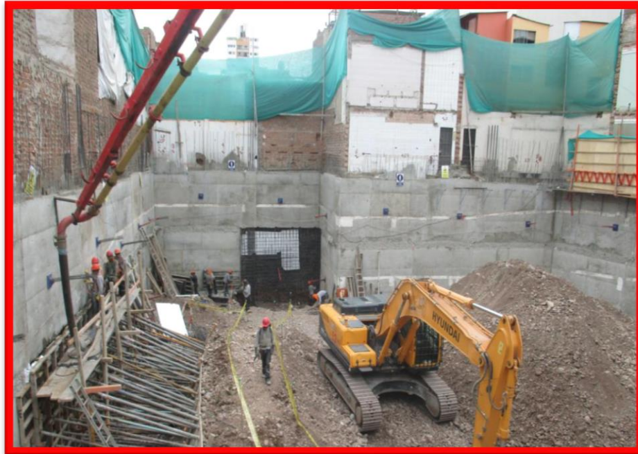
Figura 7. Uso de contrafuerte en el encofrado con excavadora.
