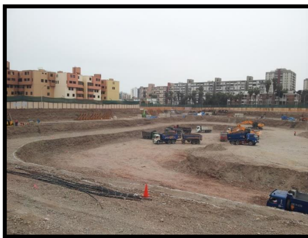
Fig. 2.1.2.3.1 Excavación masiva del primer y segundo anillo con bermas de seguridad.
