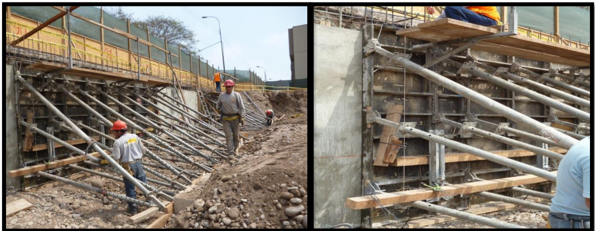
Fig. 2.1.2.3.6. A la derecha, se observa las puntales apoyados en los paneles. A la izquierda, se observa los puntales apoyados en los bloques de concreto.
