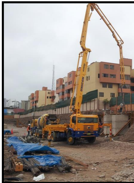
Fig. 2.1.2.3.10. Vaceado del concreto en los muros.
