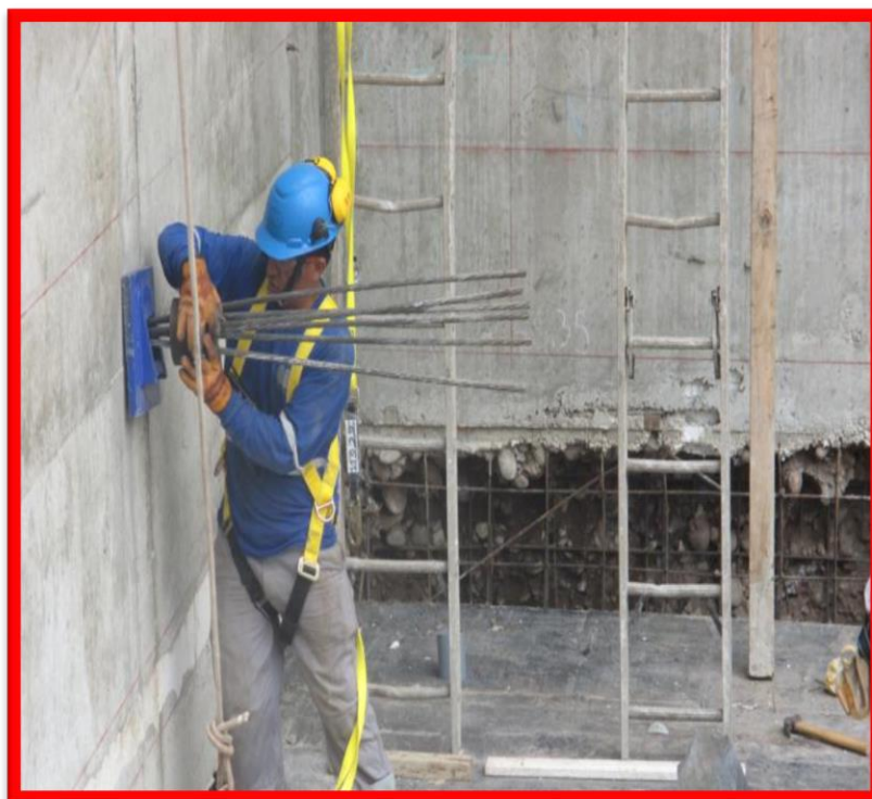
Figura 10. Tensado de anclajes de muro
