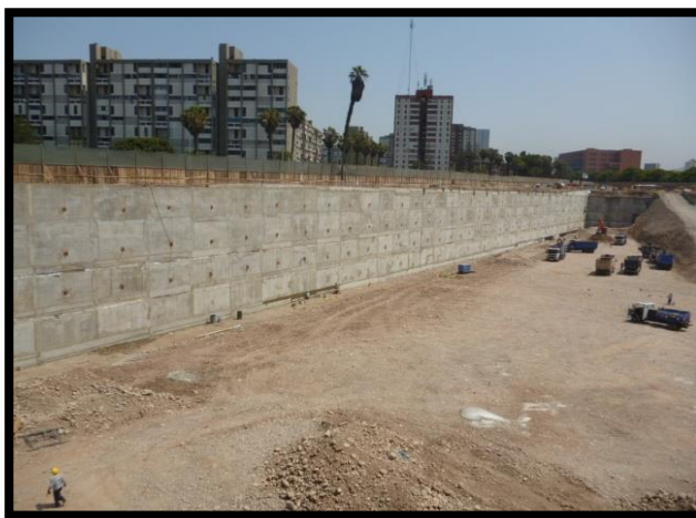
Fig. 2.1.2.3.13 En la imagen se muestra 4 anillos de muros anclados.
