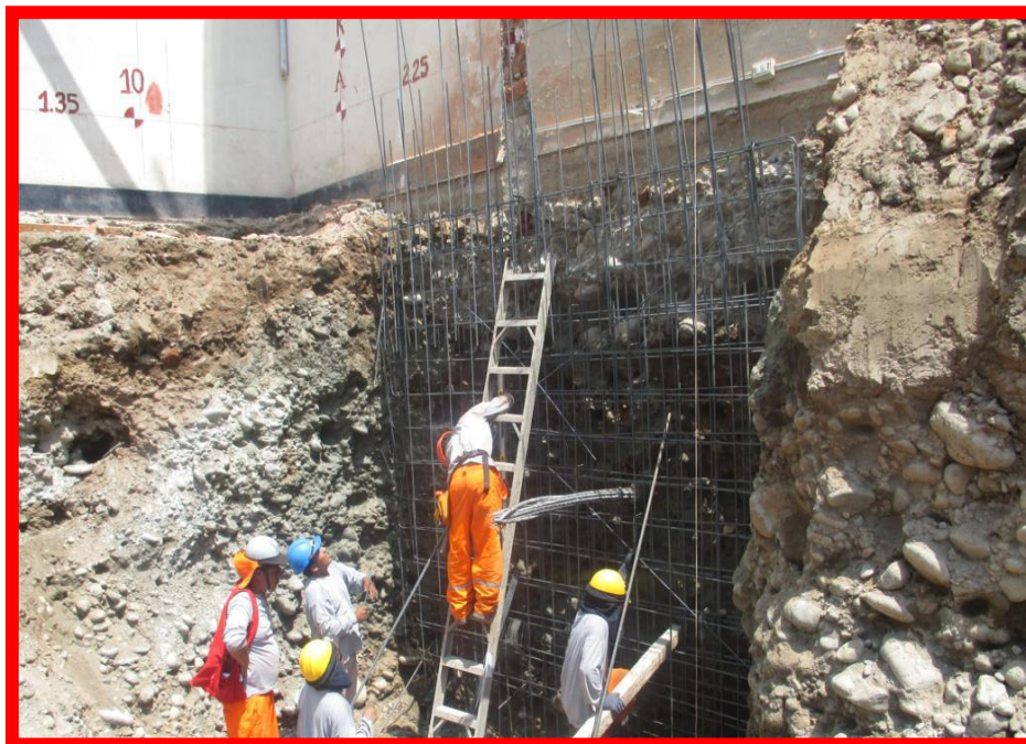
Figura 5. Colocación de acero de Muros anclados
