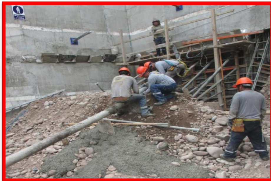
Figura 8 .Entubado de tubería para vaciado
