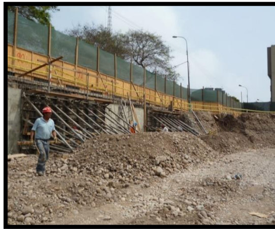
Fig. 2.1.2.3.8 Puntales apoyados en bloques de concreto enterrados.
