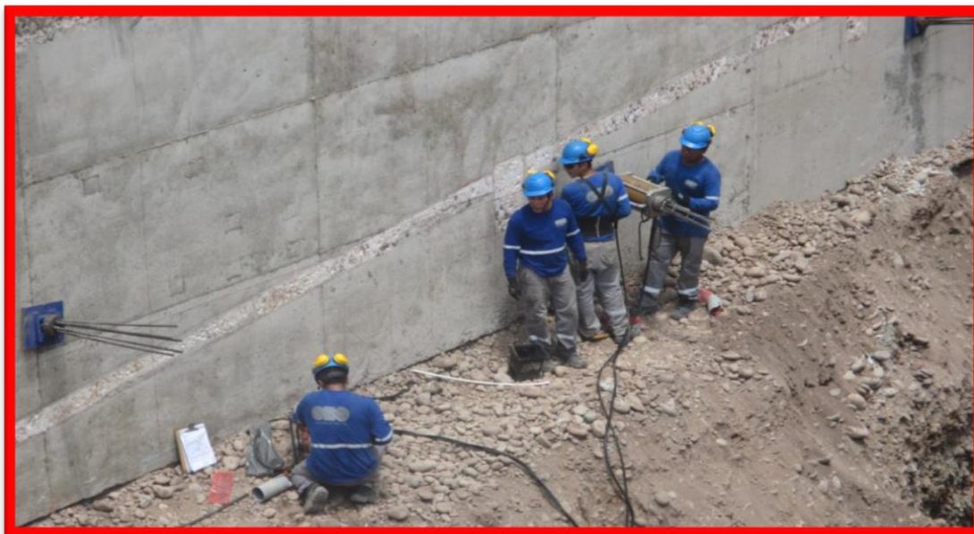
Figura 11. Tensado de anclajes de muros
