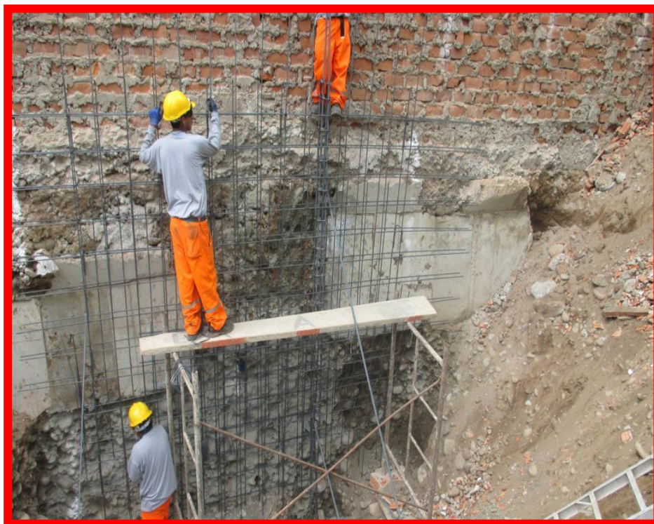
Figura 4. Colocación de acero de Muros anclados
