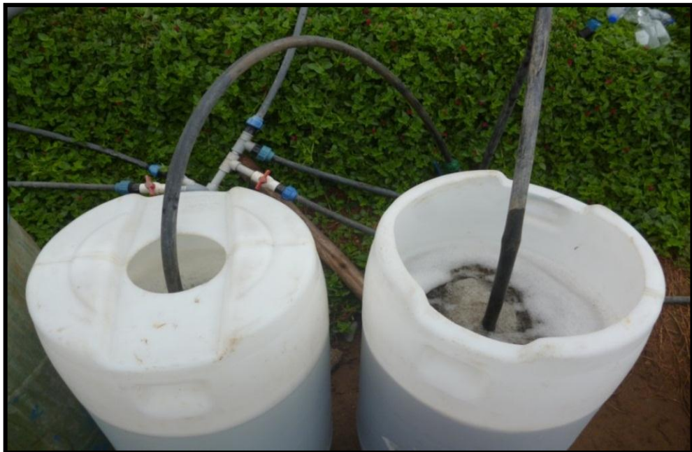
Fig. 14: Apreciación de los materiales ya instalados al cilindro
