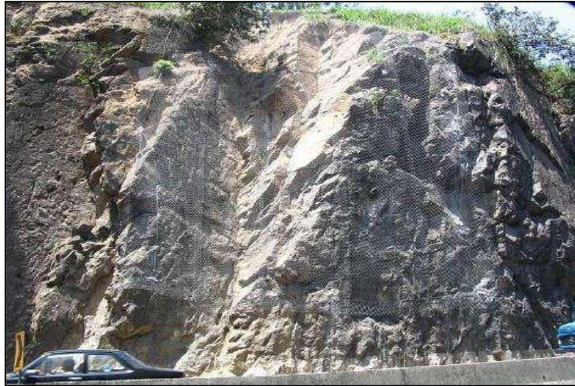
Figura 8: Malla para mitigación de deslizamiento de roca tipo planar y cuña
