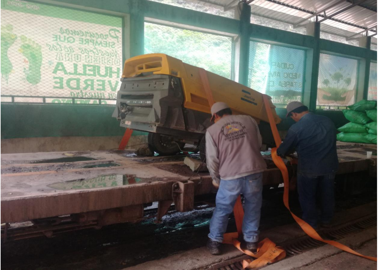
Fotografía 7: Transporte vía férrea hacia obra, (Transporte maquinarias).
