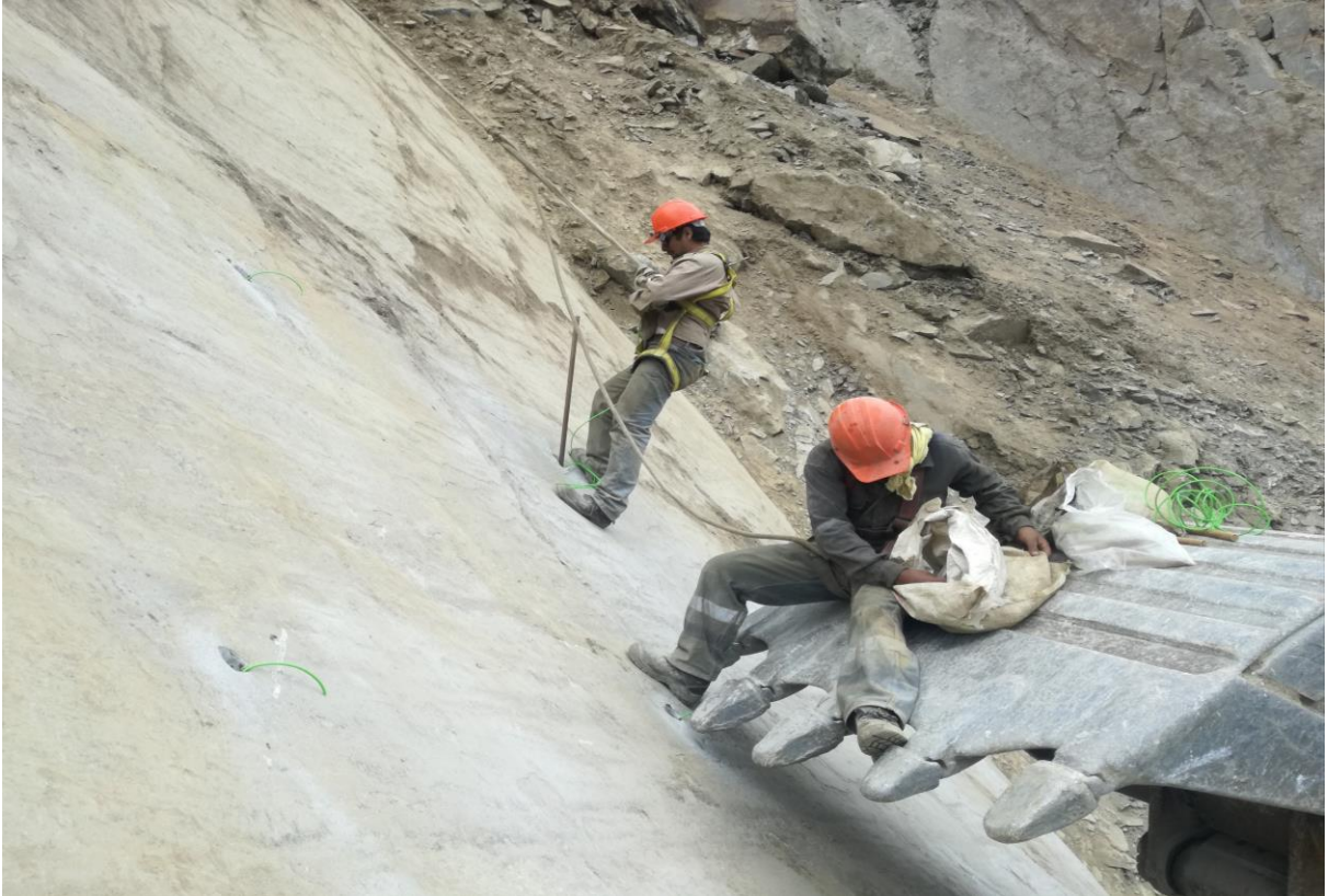
Fotografía 9: Corte de bolonería en pendientes pronunciadas de montaña, (Maniobras especiales).
