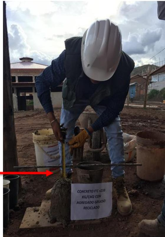
**Foto 14 Moldes de 10 x 20 cm con agregado grueso de 3/4" reciclado de pavimento rígido**
