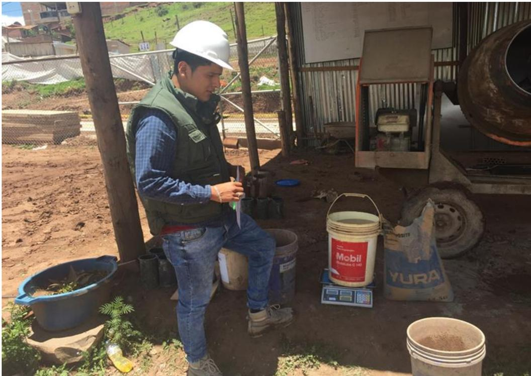
**Foto 19 Incorporación del agregado grueso de 3/4" reciclado de escombros de testigos de concreto**
