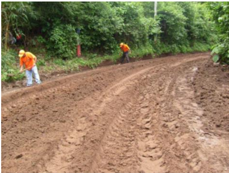
Foto 2.1 humedecimiento previa a su estabilización
