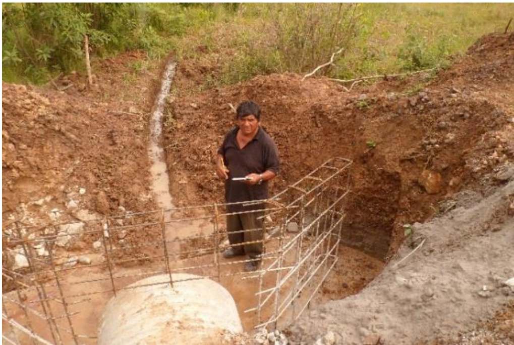
FOTO 4: SE APRECIA LA CONSTRUCCION DE ALCANTARIAS
