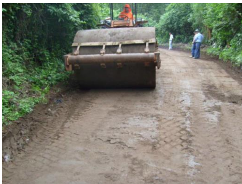
Foto 2.5 Proceso de compactación suelo-cal
