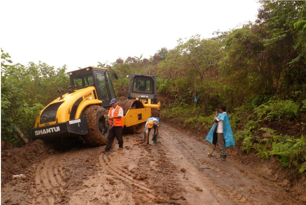
FOTO 3: SE APRECIA LA MAQUINARIA EN LA EJECUCION DEL MEJORAMIENTO
