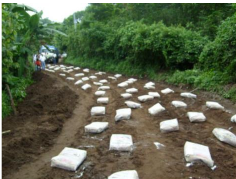
Foto 2.2 Distribución de la cal en tramos
