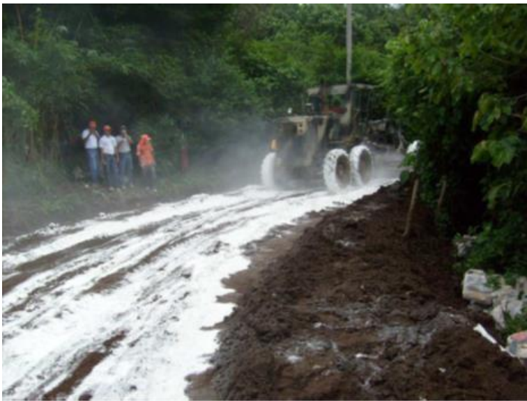
Foto 2.3 Extendido de cal previo a su mezclado
