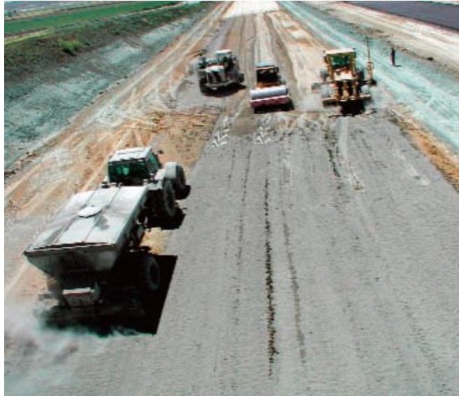
Foto 2.6 Estabilización con cemento portland
