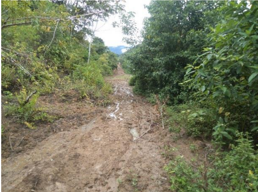
FOTO 1: SE APRECIA LA VIA EN MAL ESTADO
