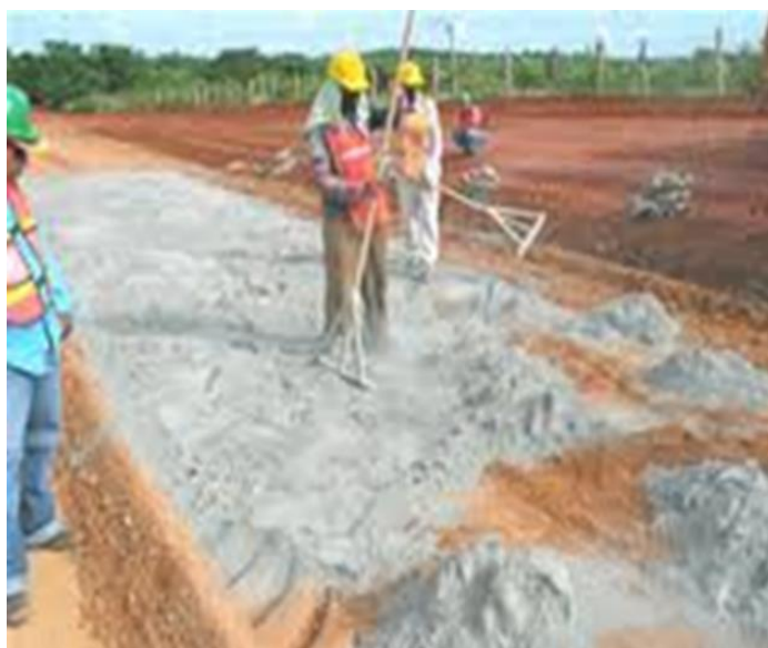
Foto 2.6 Proceso de extendido y mezclado de cemento
