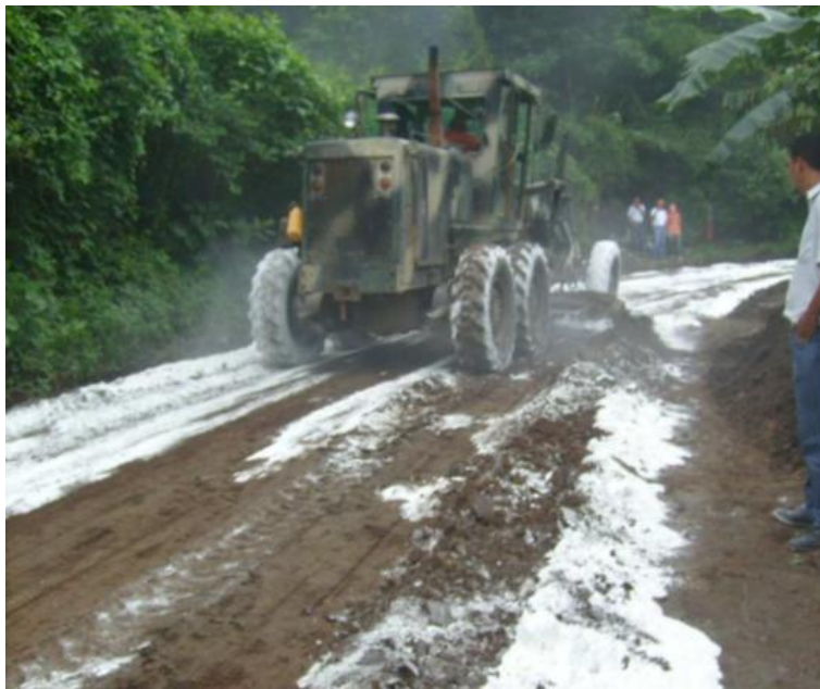
Foto 2.4 Proceso de mezclado suelo- cal
