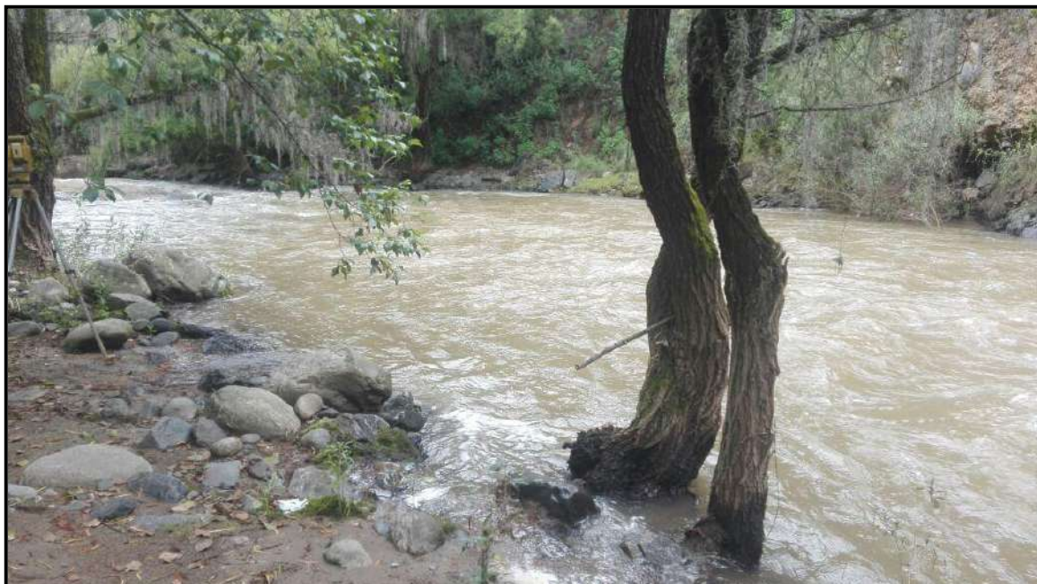
IMAGEN 09: Lugar para la construcción de la estructura hidráulica
