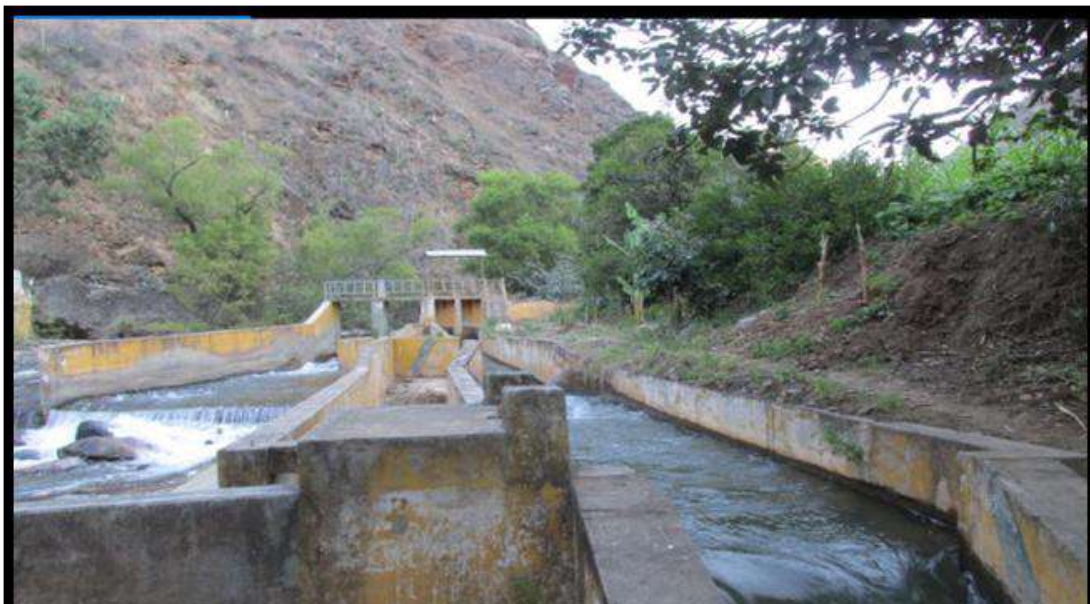
IMAGEN 01: Bocatoma actual en el Rio Cozo – Marabamba - Kotosh
