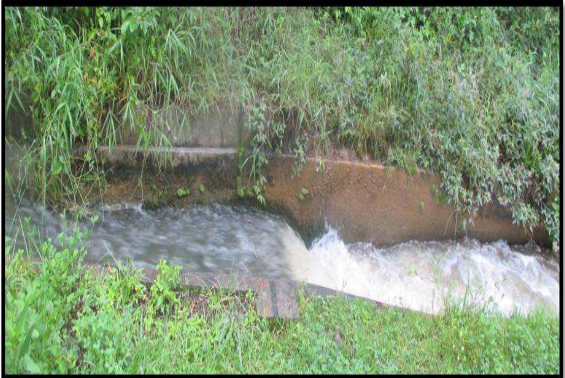
IMAGEN 03: Canal de conducción
