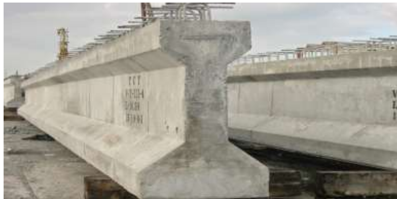
Figura 04. Trabe Concreto tipo AASHTO
