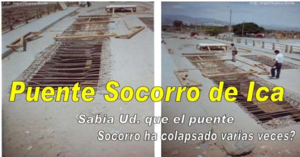
FOTO 03 Reparación del Puente Socorro
