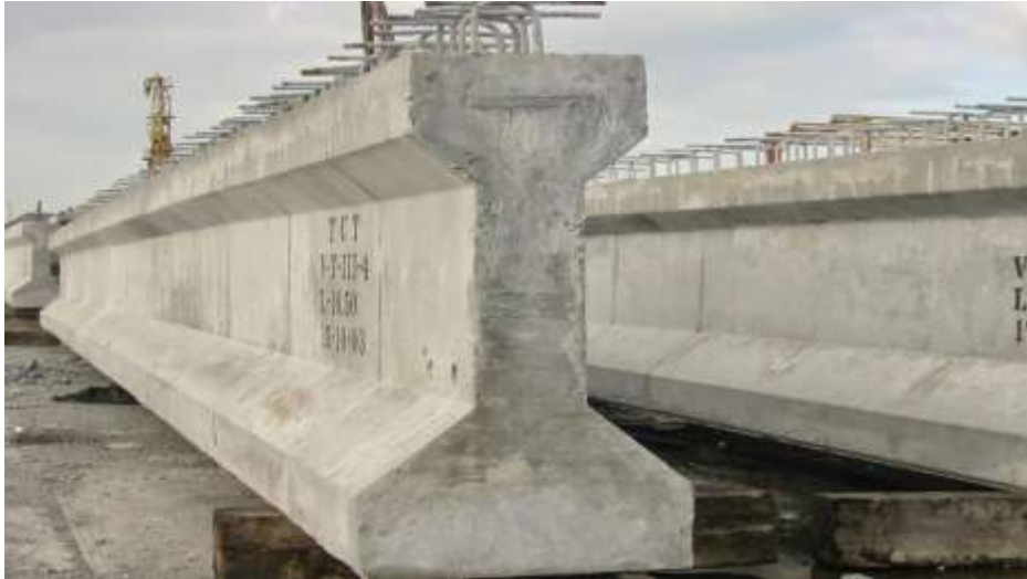
Figura 06: Trabe de Concreto
