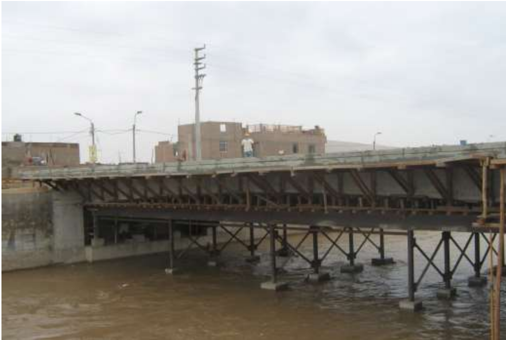
FOTO 07 Puente Puno-Sobre el Rio Ica
