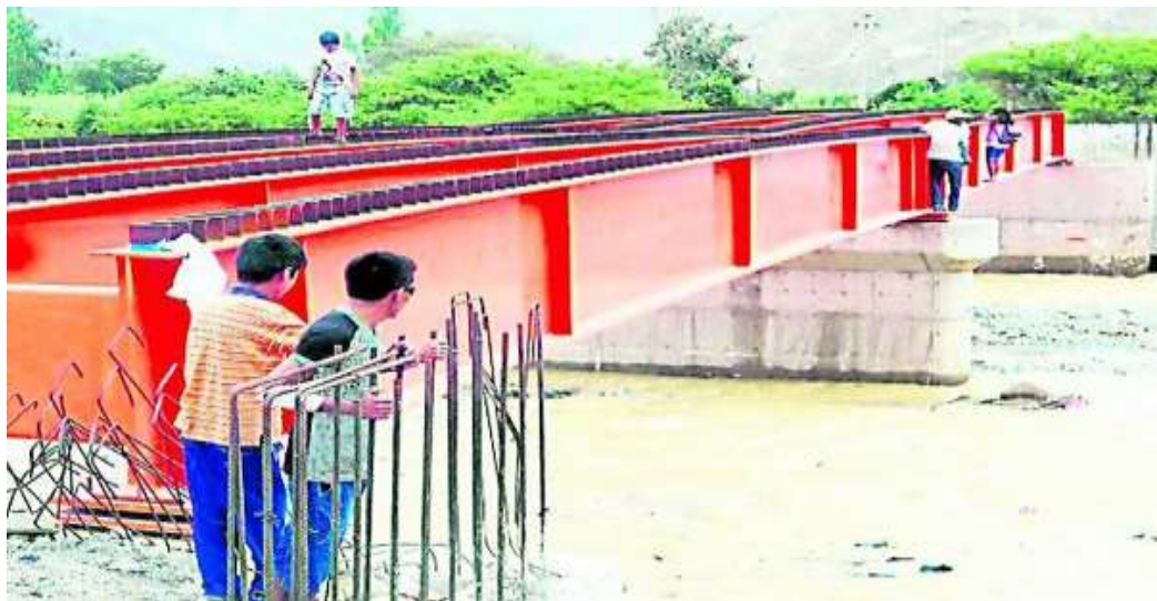
FOTO 02 Puente en el Rio Aja- Nazca-Inconcluso
