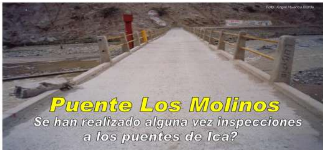
FOTO 04 Puente los Molinos
