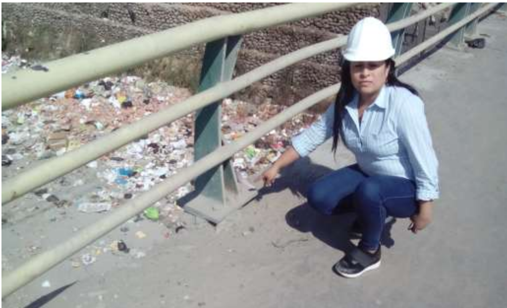
Foto N° 16, Realizando la inspección del Barandas
