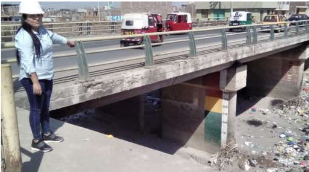
Foto N° 14, Realizando la inspección del Cause
