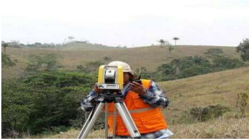
Figura 07. Vista de Trabajo topográfico de un puente.
