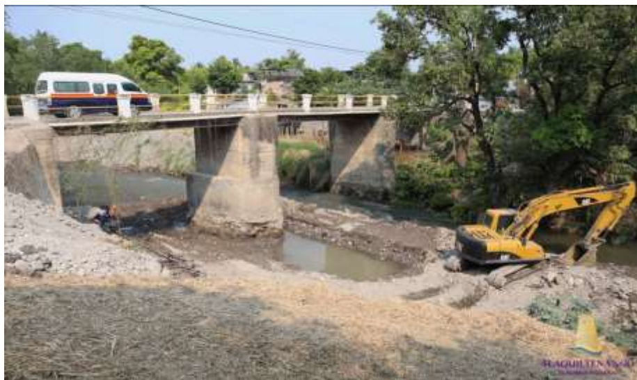
Figura 07. Vista de características hidráulicas de paso de un puente.
