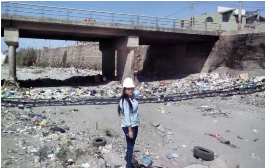
Foto N° 15, Realizando la inspección del Cause
