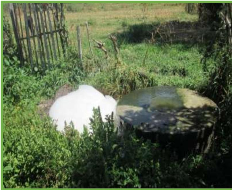
*Buzón salida del agua proveniente de la laguna de oxidación (presencia de espuma)*
