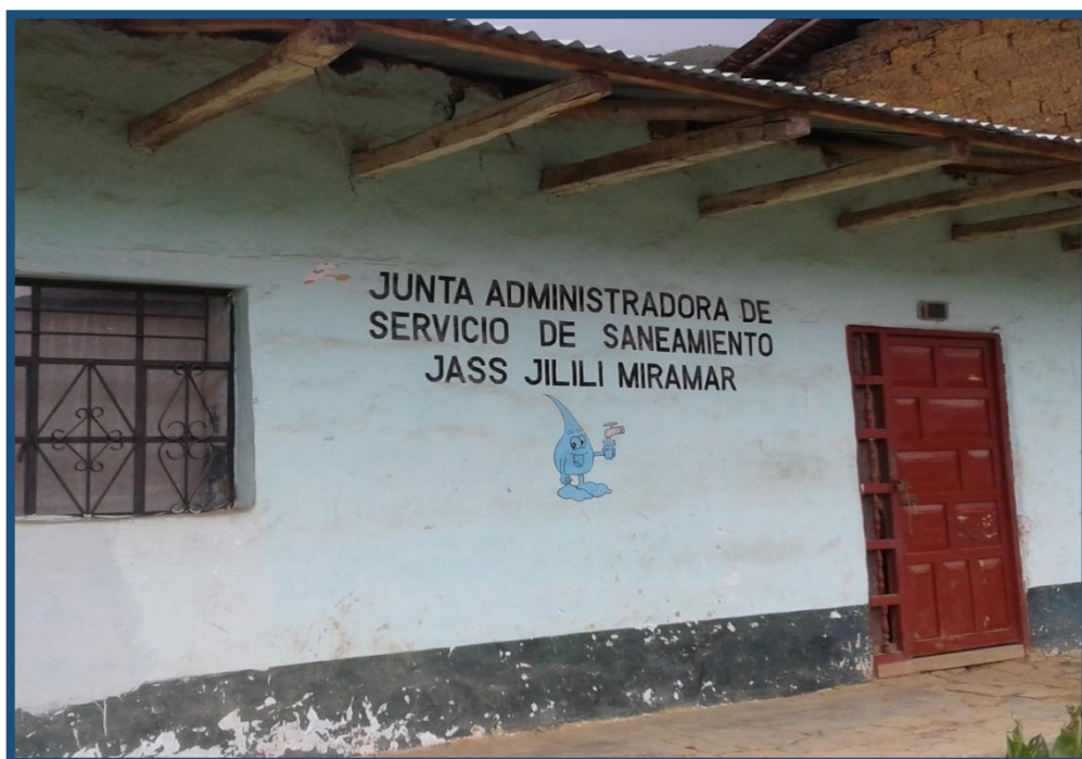
Local principal de la Junta Administradora de Servicio de Saneamiento - JASS Jilili y Miramar
