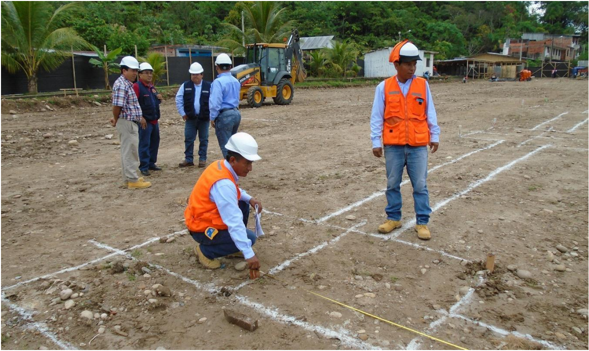
FOTO N° 3: TRAZADO DEL ÁREA DE LAS ZAPATAS Y LAS VIGAS DE CIMENTACIÓN
