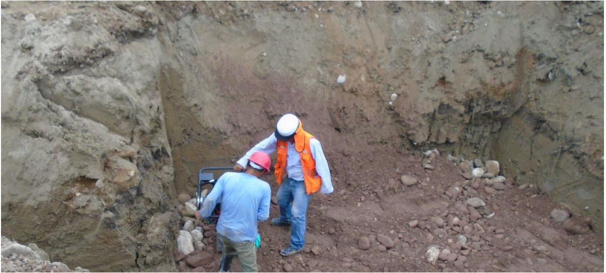
FOTO N° 9: COMPACTACIÓN DEL AREA REFORZADA
