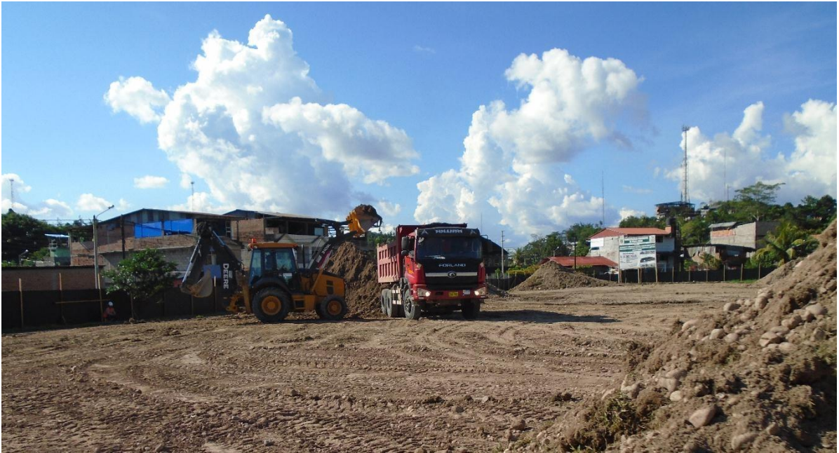
FOTO N° 1: MOVIMIENTO DE TIERRAS PARA LA EDIFICACIÓN DEL MERCADO MUNICIPAL DE AGUAYTÍA
