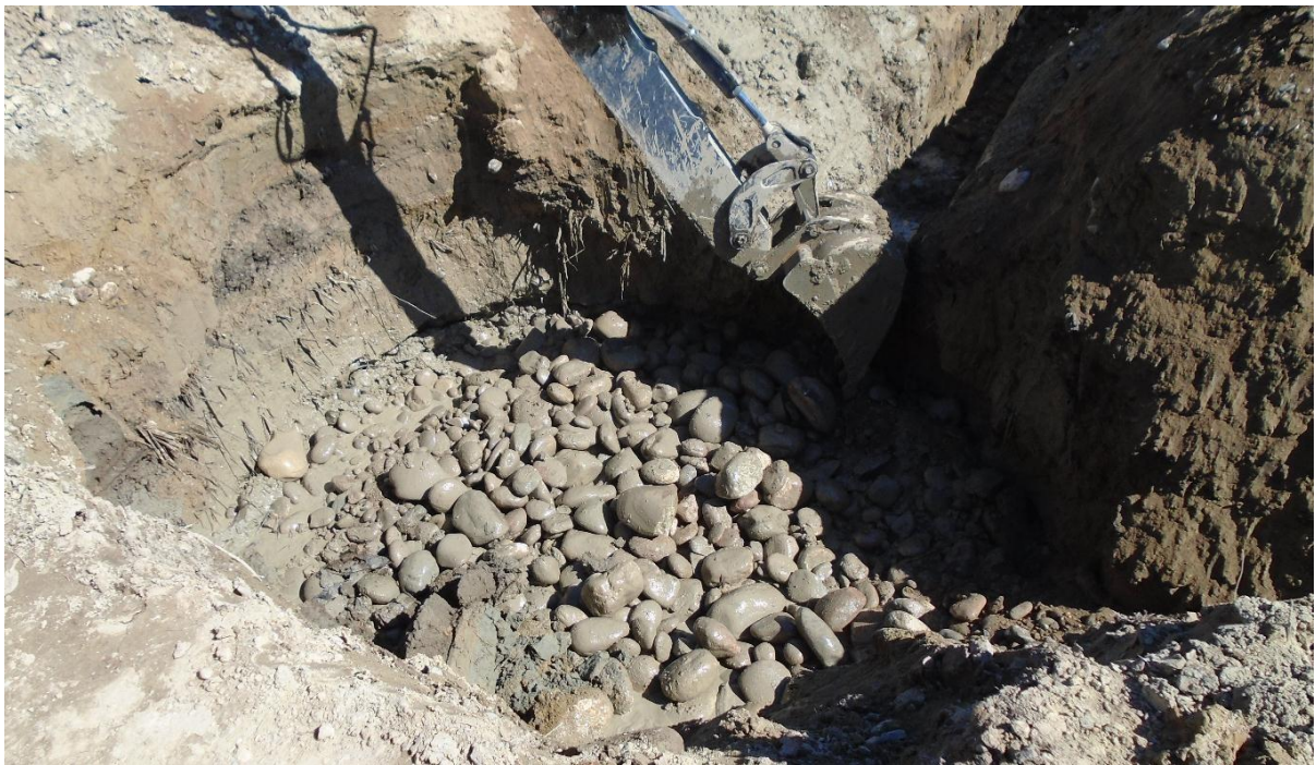
FOTO N° 7: REFORZAMIENTO DEL AREA DONDE SE UBICARÁ UNA DE LAS SUB ZAPATAS, CON PIEDRAS DE 8”.
