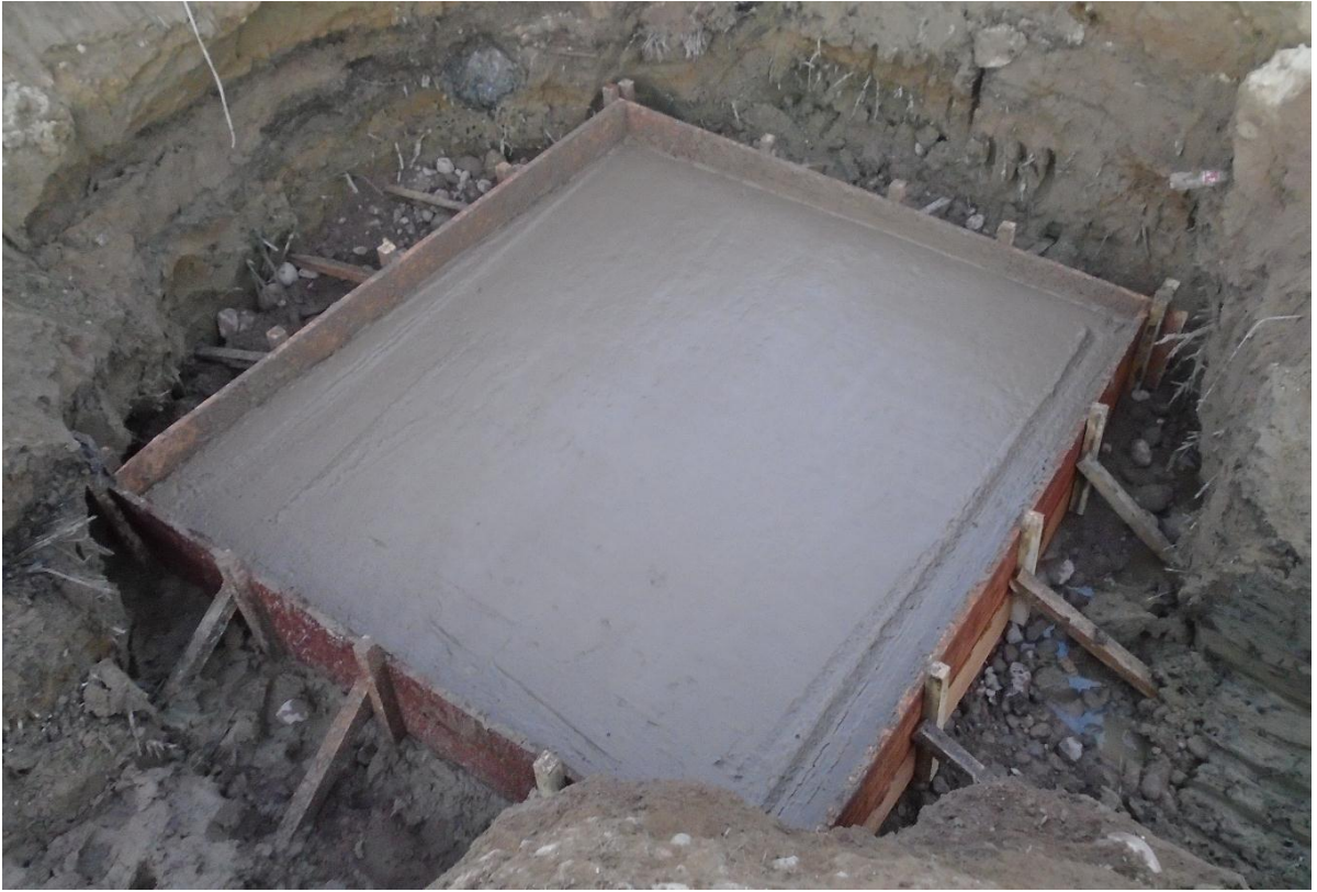
FOTO N° 11: VACIADO DE CONCRETO PARA LAS SUB ZAPATAS
