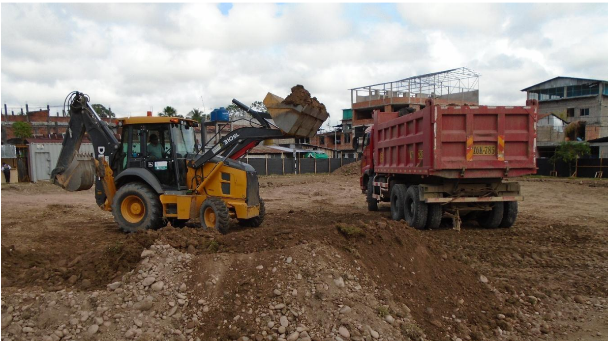
FOTO N° 2: EXCAVACIONES PARA LA FIJACIÓN DE ZAPATAS DEL MERCADO MUNICIPAL DE AGUAYTÍA
