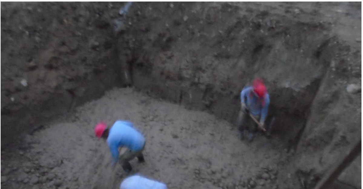
FOTO N° 10: VACIADO DE CONCRETO PARA LAS SUBZAPATAS
