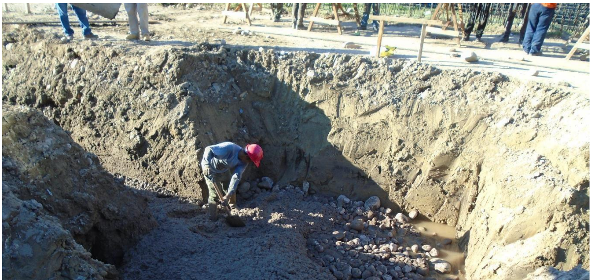
FOTO N° 8: REFORZAMIENTO CON PIEDRA Y HORMIGÓN DE LA ZONA DE CIMENTACIÓN
