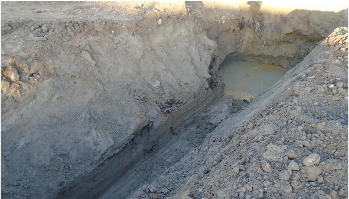
FOTO N° 6: DRENADO DEL AGUA ACUMULADA EN LAS EXCAVACIONES DE LA CIMENTACIÓN
