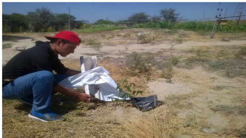
FOTOGRAFÍA N° 11: COLOCACIÓN DE SISTEMA DE RIEGO POR GOTEO
