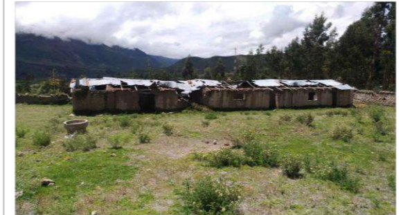
IMAGEN 1: VISTA GENERAL DEL PABELLON N°2
