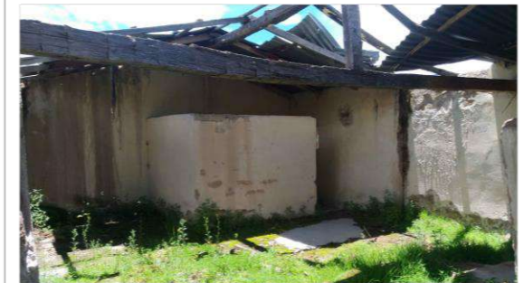
IMAGEN 2: VISTA INTERIOR DEL PABELLON N°2
