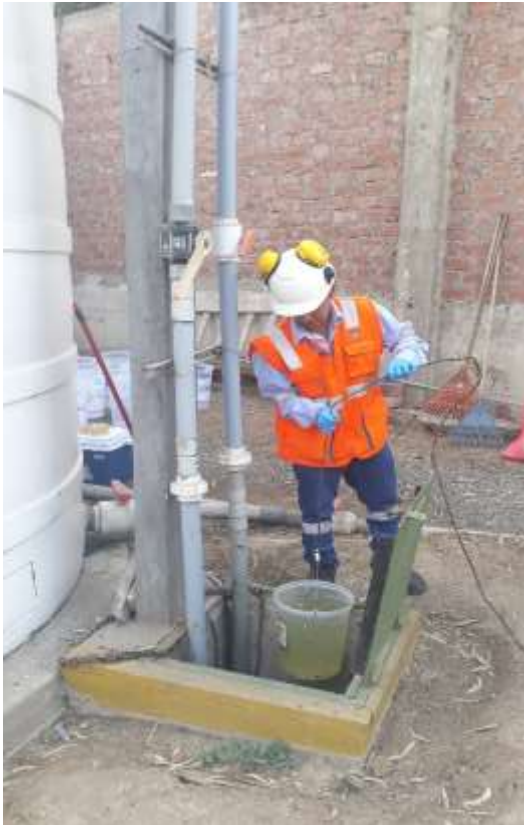
FOTOGRAFIA N° 17: Toma de nuestras muestras antes de entrar a la Planta de Tratamiento de Aguas Residuales de la Universidad Alas Peruanas sede Pachacamac
