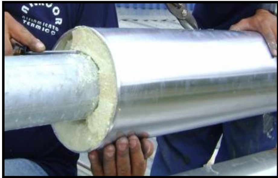
Figura 4: Instalación de aislamiento térmico en tuberías de vapor
