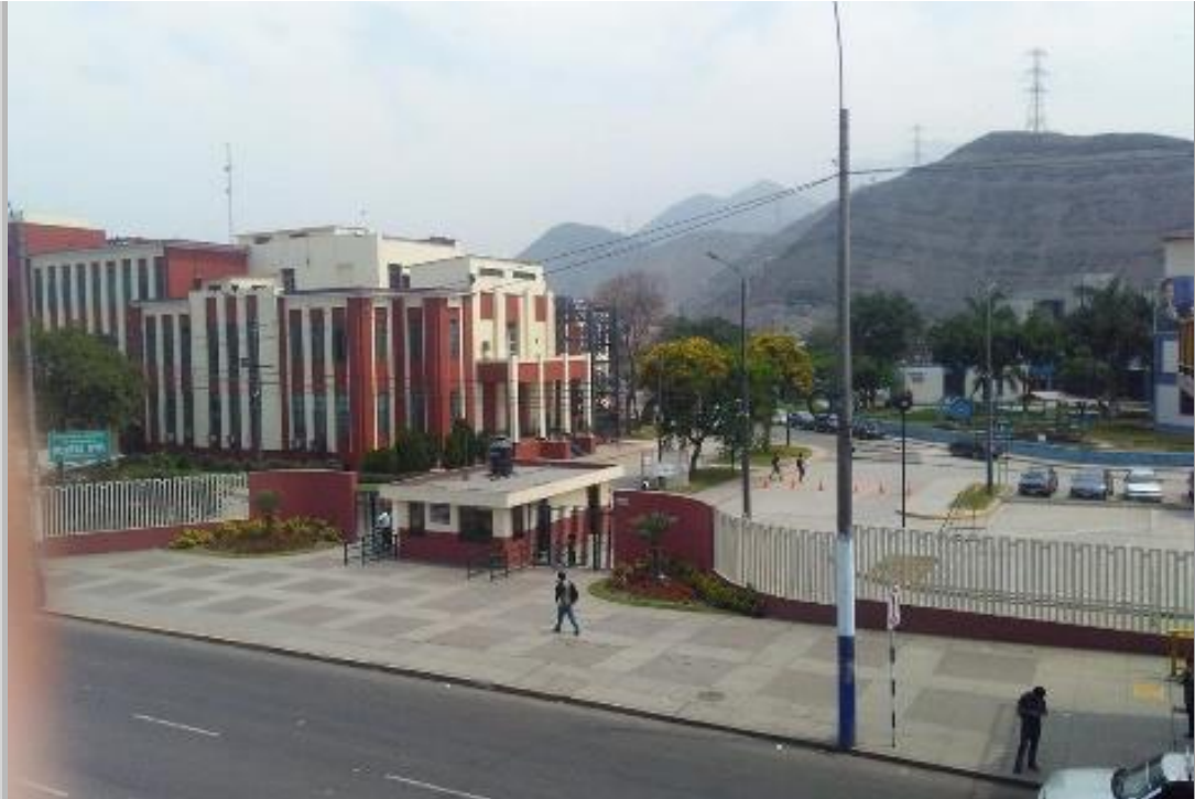
Fotografía N° 17: Frontis puerta N° 3 Universidad Nacional de Ingeniería del Perú. Av. Túpac Amaru 210, Rímac.
