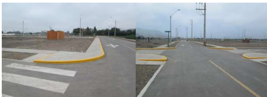
Figura n° 88: Pista terminada – calle 22.
