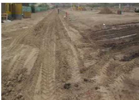
Figura n °11: Conformación escarificada de la subrasante.
