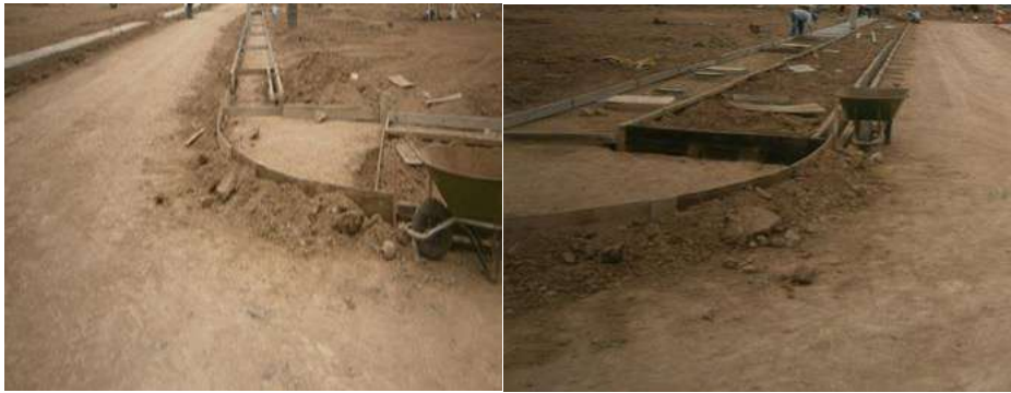
Figura n °72: Encofrado de vereda martillo.
