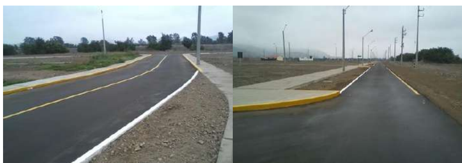
Figura n °89: Pista terminada calle 18.
