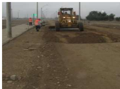
Figura n° 15: Tendido del material afirmado
