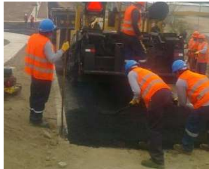
Figura n° 24: Colocación de la carpeta asfáltica en la calle 13.
