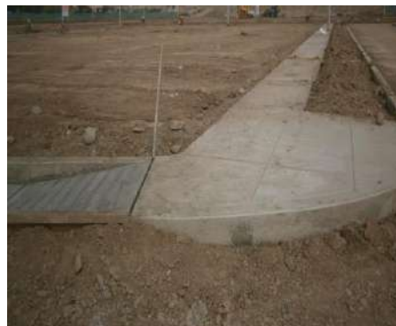
Figura n °40: Rampa de concreto.
