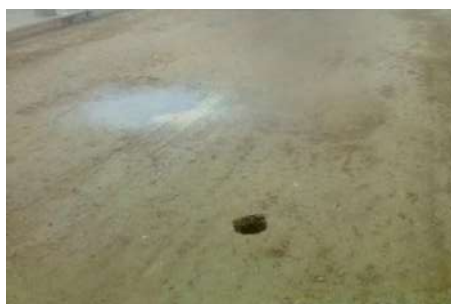
Figura n °18: Prueba de compactación en la calle 21.
