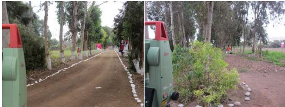
Figura n° 48: Replanteo topográfico- Alameda Los Sauces Sur.
