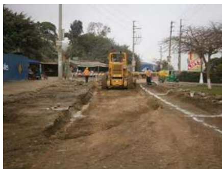
Figura n ° 9: Corte a nivel subrasante (parte externa).
