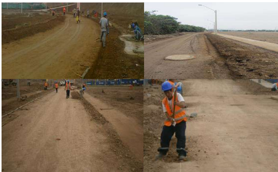
Figura n ° 78: excavación de sardinel sumergido.
