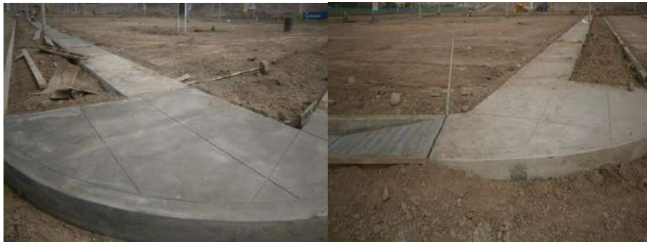
Figura n °76: Desencofrado de vereda de martillo y rampa.
