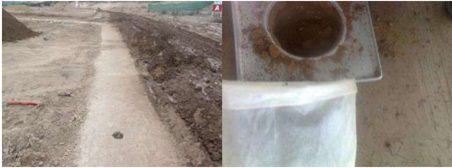
Figura n °71: Prueba de compactación vereda Mz A1.
