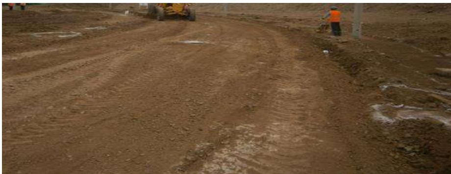
Figura n° 70: Compactación de vereda.
