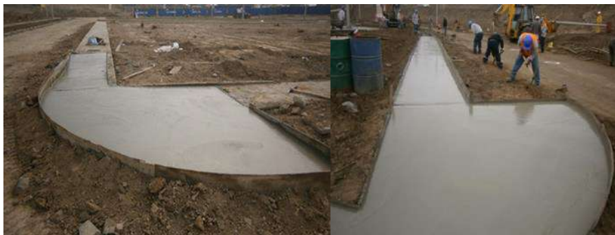
Figura n° 75: Encofrado y vaciado vereda martillo.
