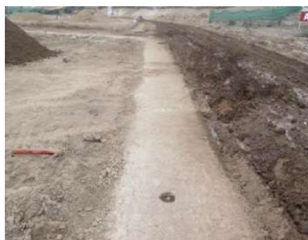
Figura n °35: Prueba de compactación de vereda.
