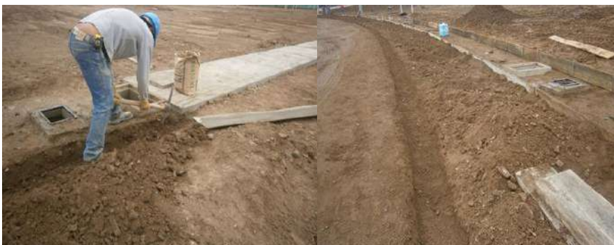
Figura n °73: Encofrado de vereda.
