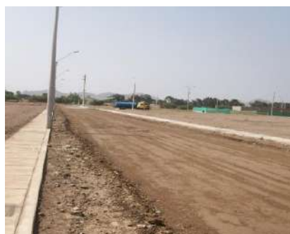
Figura n° 16: Tendido del material afirmado calle 16
