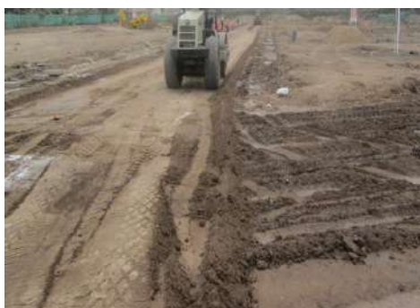
Figura n ° 12: Compactación con rodillo vibrador liso.
