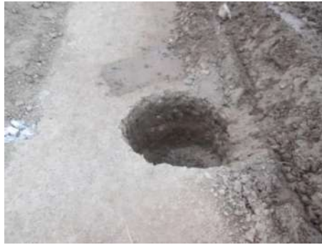
Figura n °13: Prueba de compactación de la subrasante.
