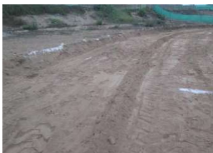
Figura n °8: Corte del terreno a la altura de la subrasante.
