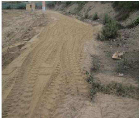
Figura n °10: Relleno con material propio a nivel subrasante
