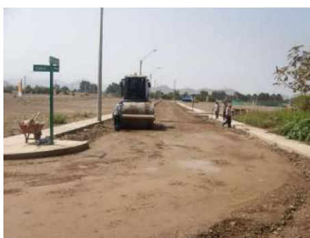
Figura n °17: Conformación y compactación de la base - calle 20.
