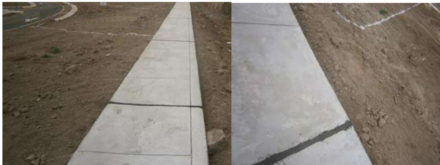
Figura n °77: Junta de dilatación de vereda.
