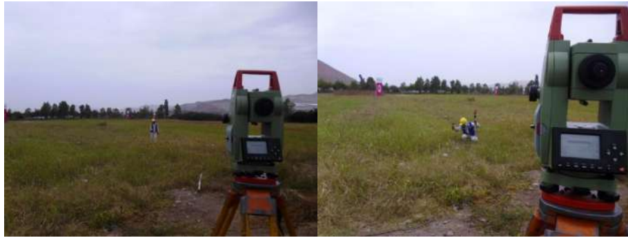
Figura n° 53: Replanteo topográfico Mz Q-R.
