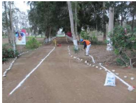
Figura n° 7: Replanteo de controles topográficos Alameda Las Casuarinas.
