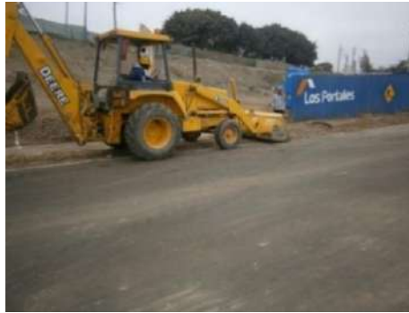
Figura n° 14: Eliminación de material excedente.
