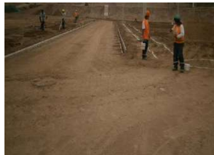
Figura n ° 31: Encofrado del sardinel sumergido.
