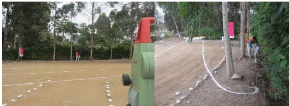
Figura n° 49: Replanteo topográfico y tizado Mz A2.
