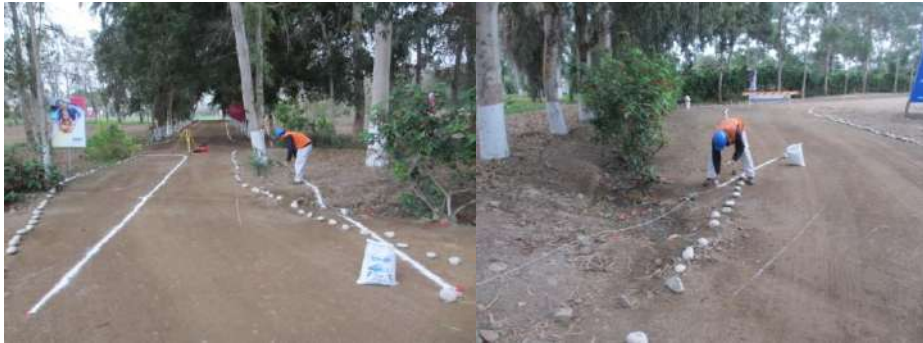
Figura n° 47: Replanteo topográfico – Alameda Central.
