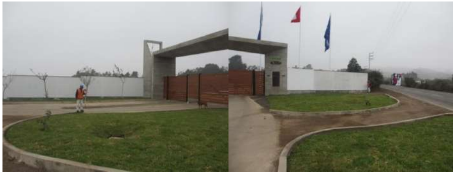
Figura n° 54: Replanteo topográfico puerta principal.
