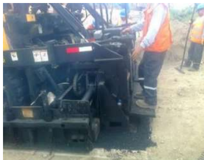
Figura n° 25: Colocación de la carpeta asfáltica en la calle 14.
