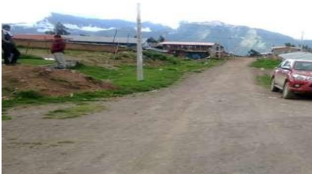
Figura 6 Final de la vía del proyecto
