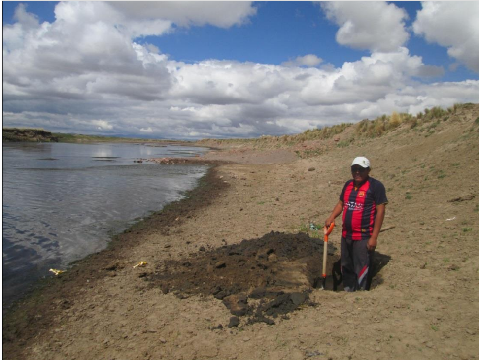
Fotografía 5. Se aprecia la excavación de calicata en la orilla del río.
