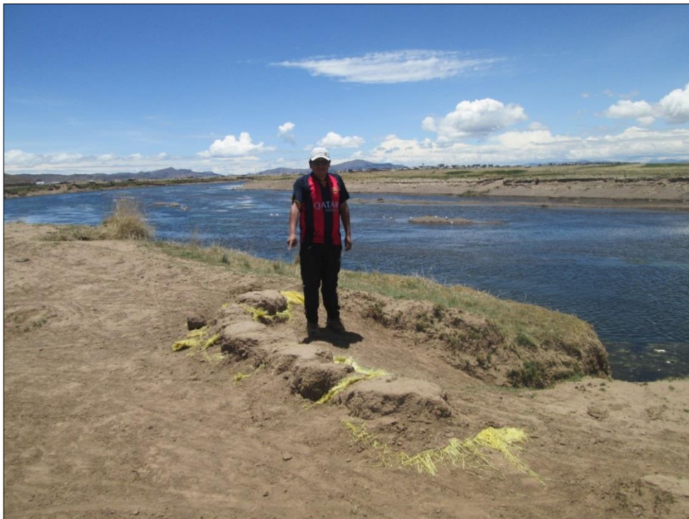
Fotografía 2. Se aprecia la defensa al desborde, con sacos llenados de tierra.
