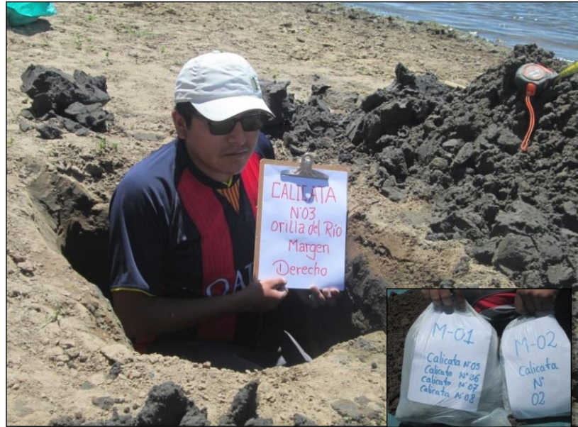
Figura 14. Excavación de calicatas y muestreo de suelos. Fuente: fotografía propia.
